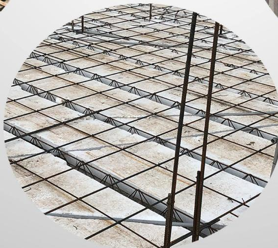
3. Instalación de EPS, armadura de distribución e instalaciones
